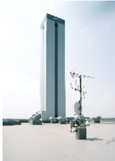
① 煙突外観 (5階)
