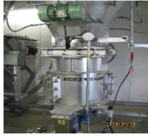
しょうせっかいていりょうきょうきゅうそうち ②消石灰定量供給装置
