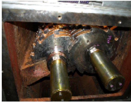
② 破砕機内部
